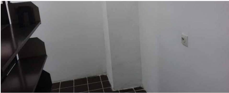
Stan pomieszczenia magazynowego przed i po remoncie
